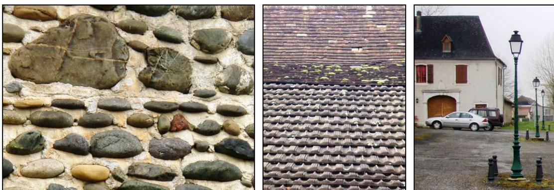
**Figure 54 : Les galets constituent le matériau le plus employé dans la construction des murs traditionnels. Concernant les couvertures, les ardoises et les tuiles (mécanique, plate ou canal) se répartissent les toits © ETEN Environnement**
