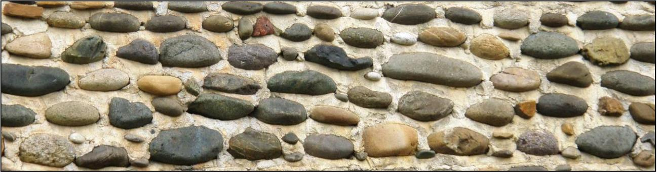
**Figure 34 : Les galets mélangés au mortier étaient traditionnellement utilisés dans les murs © ETEN Environnement**
