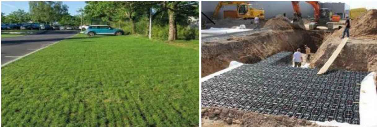
*Exemple de stationnement perméable et de bassin de rétention sous voirie. Source : Source : Rebeyrol Architectes.*
