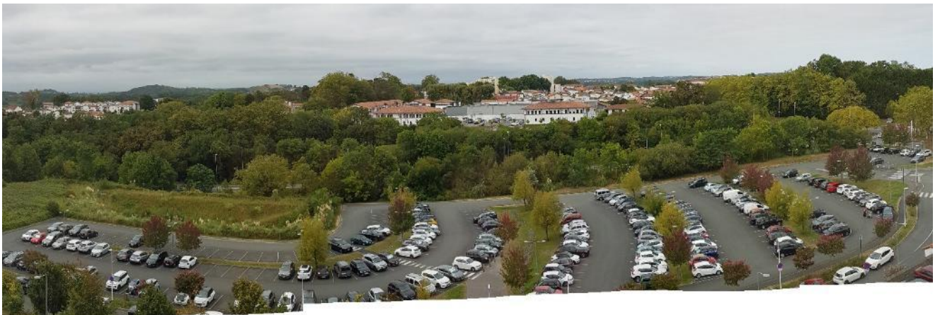
Site d'implantation du projet, vue depuis la clinique Belharra - Source : SITU, APGL, 08-2023
