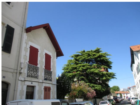
Ensemble bâti et paysager rue Général Bourbaki,
