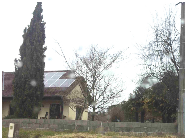
Installation photovoltaïque sur une maison
