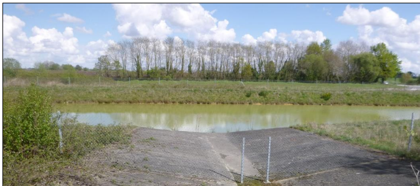
Bassin de gestion des eaux pluviales © ETEN Environnement
