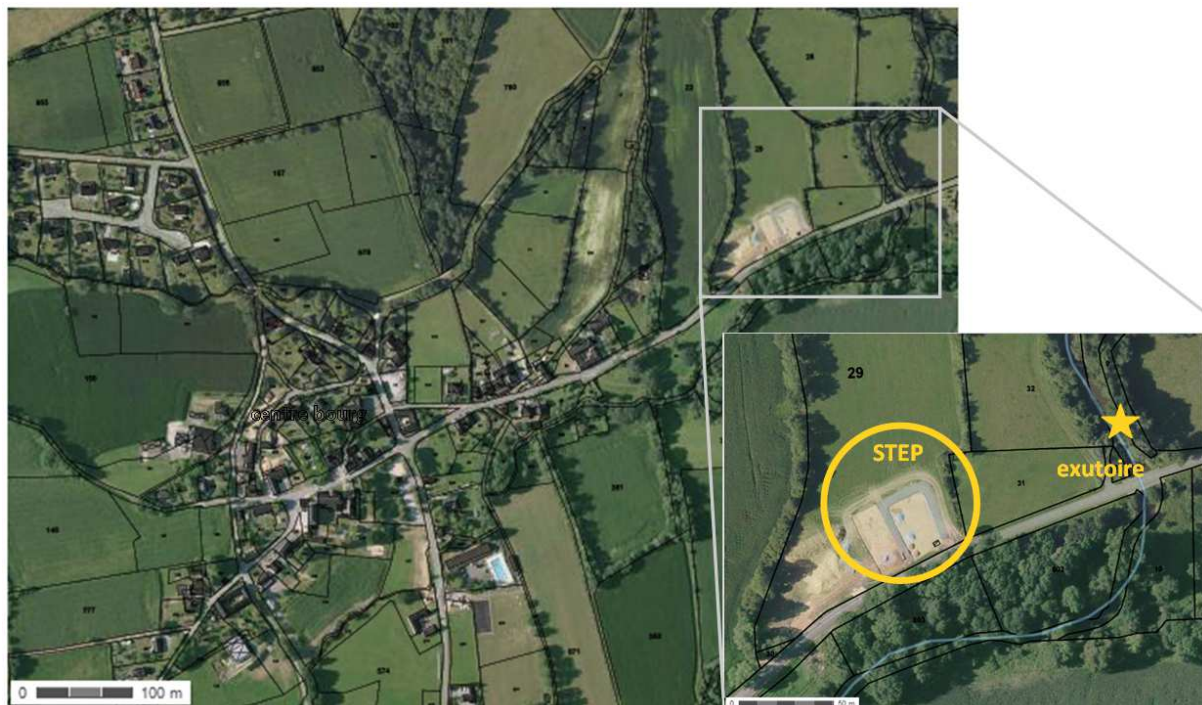
Localisation de la station d'épuration (Source : Géoportail)
