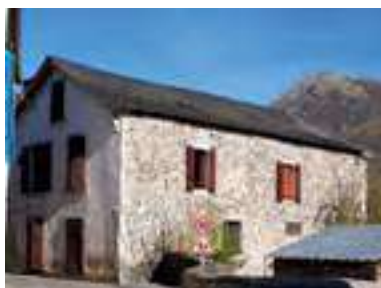
Toiture simple à deux pentes. Bielle.
