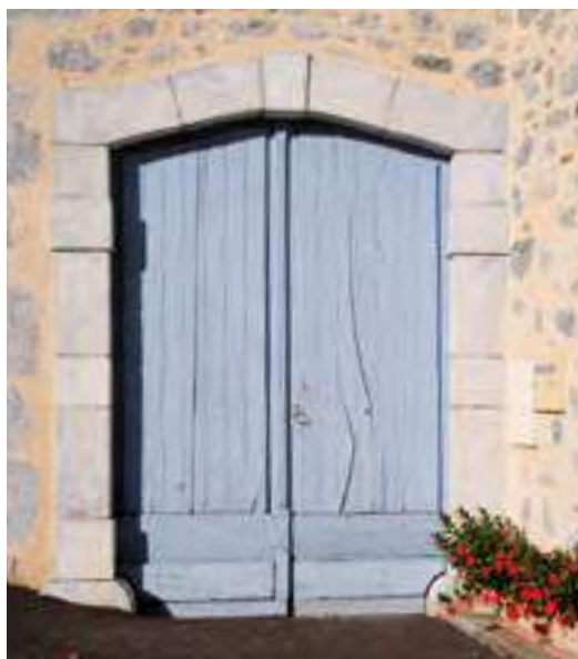
Porte à planches et contre-planches. Bescat.
