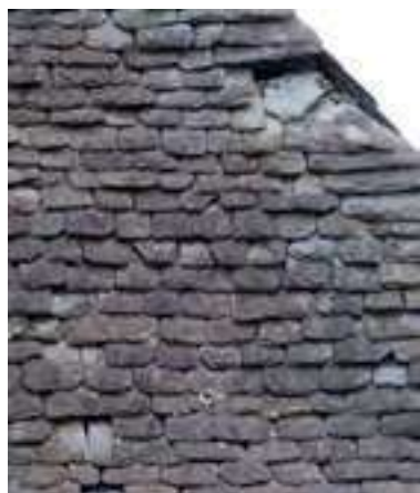
Ardoises épaisses posées au clou. Oloron Sainte-Marie.
