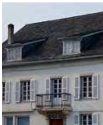
Lucarnes rampantes. Issor.
