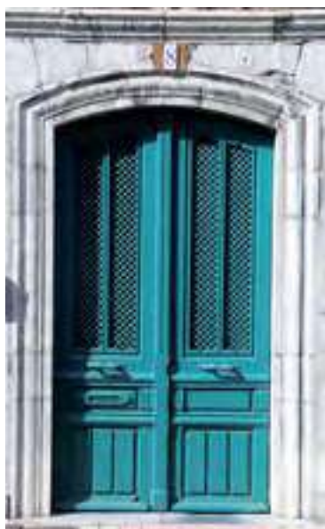
Porte avec sa ferronnerie. Oloron Sainte-Marie.
