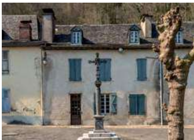
Le faîtage est parallèle à la rue. La porte n'est pas centrée. Sarrance.
