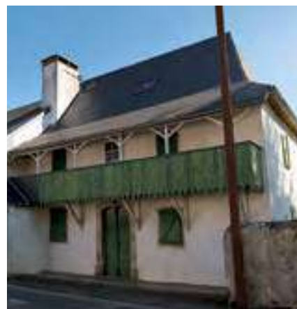
Le pan du coyau est prolongé pour servir de couverture à la galerie ouverte. Féas. Source : VPAH © C. HERBAUX.
