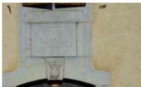
Badigeon coloré au pigments minéraux, finition talochée aux sables locaux et enduit coloré à pierre vue.
