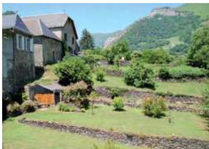
Murs de soutènements entre parcelles
