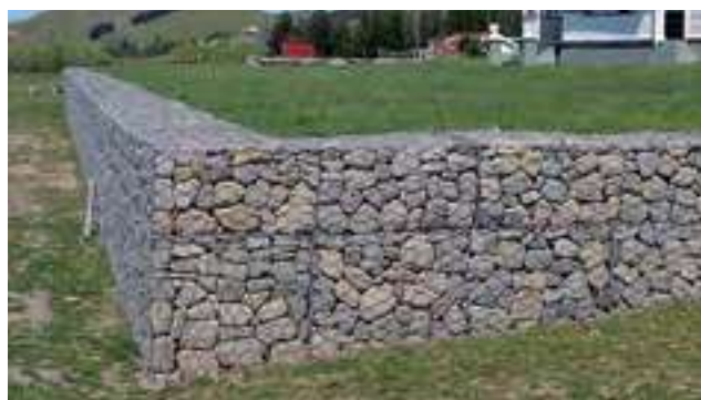
Exemple de murs gabions en soutènement.
