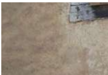
Badigeon coloré au pigments minéraux, finition talochée aux sables locaux et enduit coloré à pierre vue.
