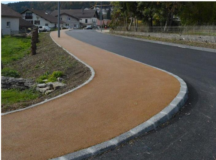
**Exemple de bordure en béton**
