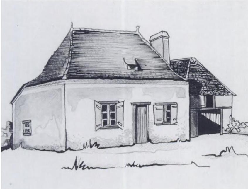
**Exemple de construction traditionnelle du Béarn avec tuile picon, génoise et coyau**
