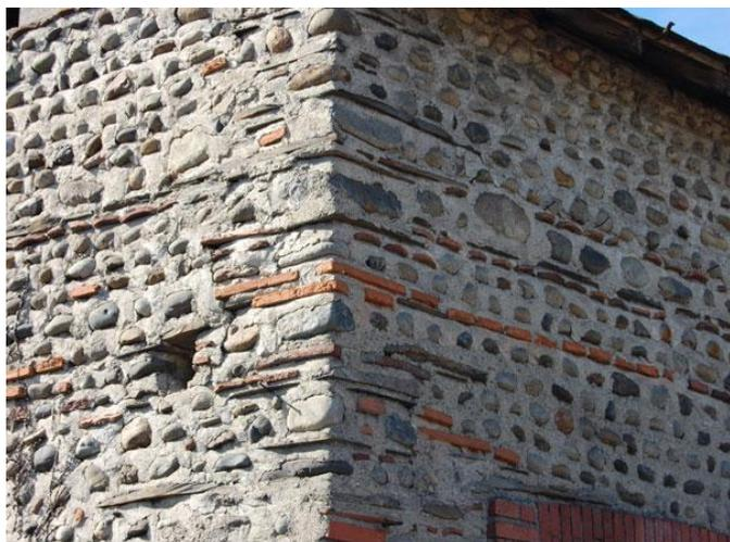
**Mur hourdé en galet/brique traditionnel appareillage horizontal en ligne**
