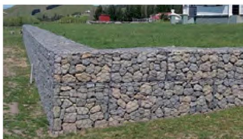
Exemple de murs gabions en soutènement.
