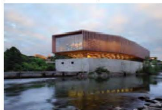
Médiathèque des Gaves, Pascale Guédot Architecte.
