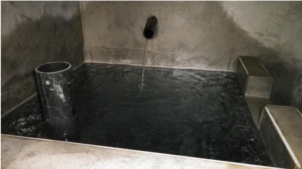
Figure 17 : Photo de l'intérieur de l'ouvrage aval (bassin de décantation) - captage Lahünde
