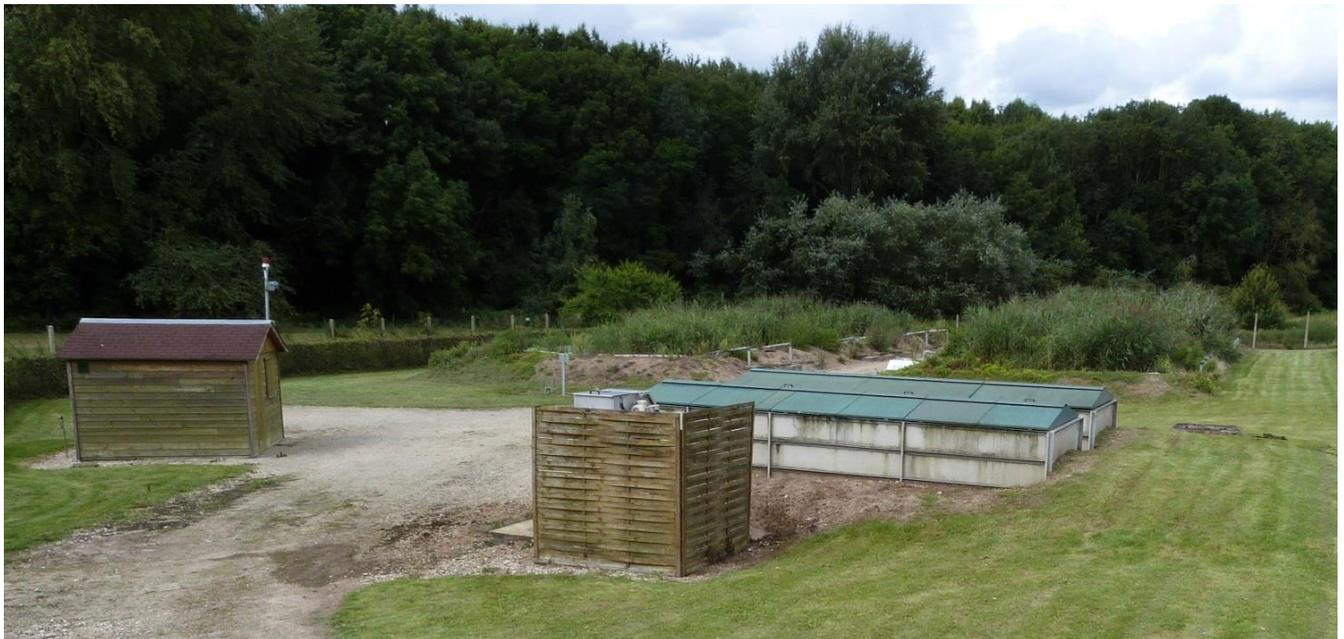
**Figure 25 : exemple de STEP à disques biologiques avec lagunes**
