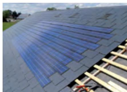
Certains fabricants proposent aujourd'hui des systèmes de capteurs solaires thermiques dissimulés sous ardoise. L'ardoise naturelle sert de capteur d'énergie et le dispositif passe inaperçu en toiture et dans le paysage. Les ardoises photovoltaïques évitent la pose des capteurs avec un châssis en saillie sur le plan du toit.
