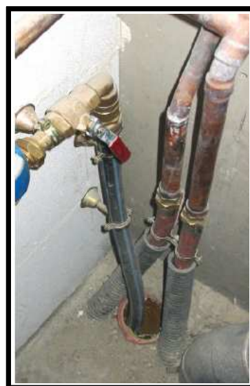
Calfeutrage des entrées de réseaux
