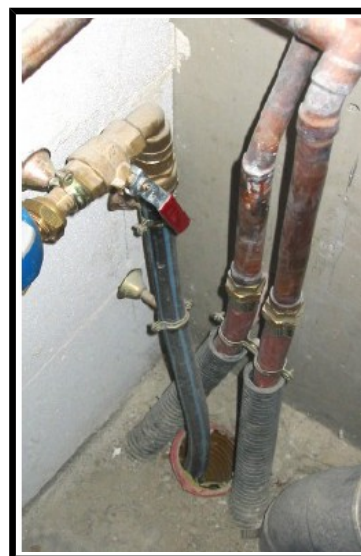
Calfeutrage des entrées de réseaux
