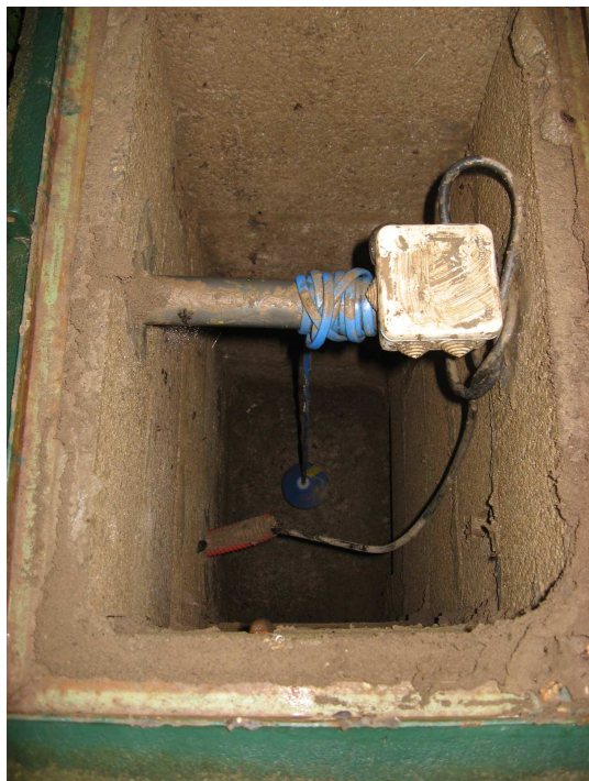
Alarme type interrupteur à mercure (poire) placée à 1.40 m avant débordement. Vue intérieur
