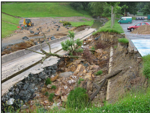
Erosion et glissement entre le parking et le chenal d'écoulement
