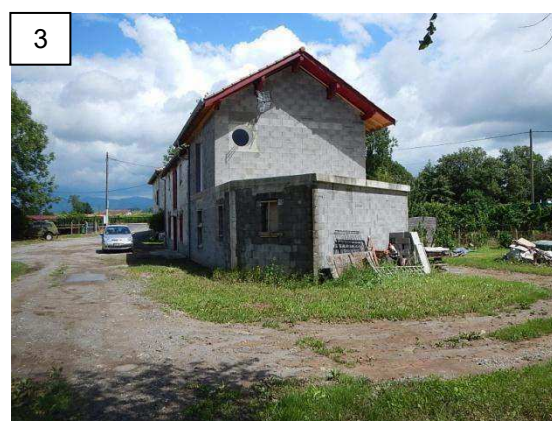
Bâti en aval de la RD15
