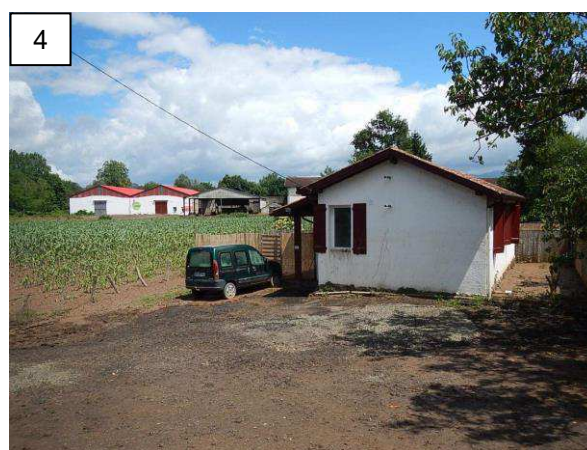
Habitation impactée : environ 1,8 m d'eau au niveau du mur extérieur – repère de crue UNB04
